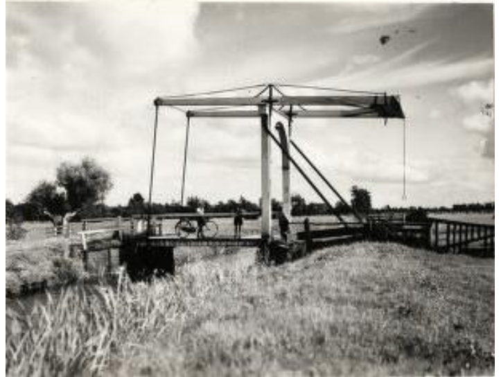
Figuur 20. Klapbrug Lutjegast, Foto van de tweede klapbrug ter hoogte van de kerk te Lutjegast.
